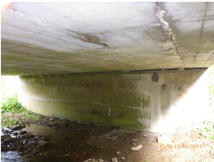
Opěra 2 - protékání s výluhy na pracovních spárách
