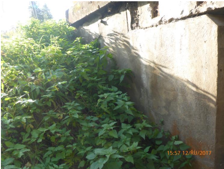
Křídlo opěry 1 vpravo. Projevy protékání křídla, trhliny s výluhy na křídle
