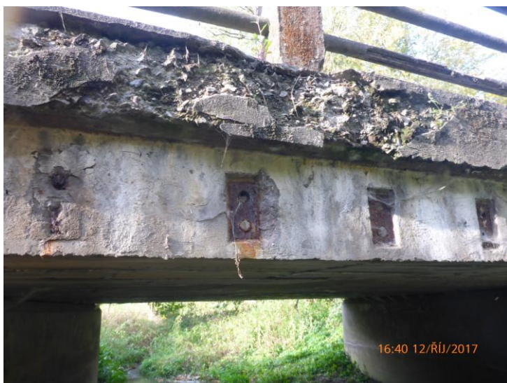
Stav pravé římsy, silné potékání boku nosníku č.16 a koroze kotevních desek příčného předpětí s odtržením jejich obetonování
