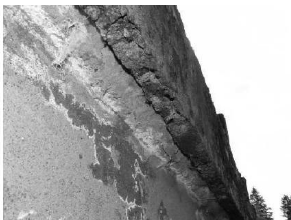
Detail- pohled na římsu, stopy zatékání
