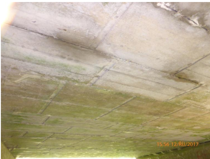
Podhled nosné konstrukce – projevy protékání nosnou konstrukcí ve spárách mezi nosníky
