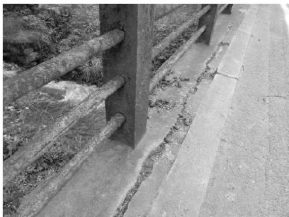
Detail - trhлина mezi římsou a obrubníkem
