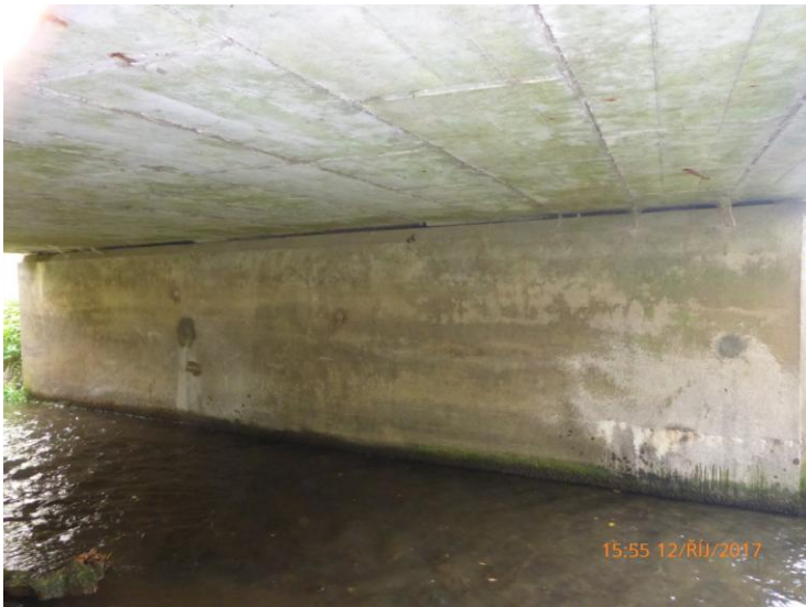
Opěra 1-protékání s výluhy na pracovních spárách
