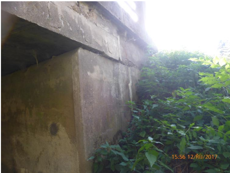
Křídlo opěry 1 vlevo. Prosakování vlhkosti a výluhy.
