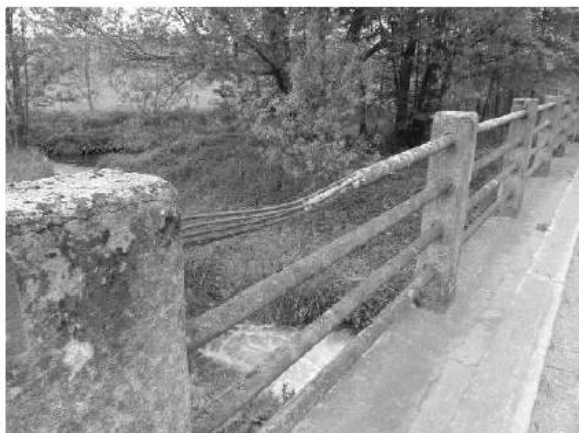
Detail-zábradlí, poškozené ŽB madlo
