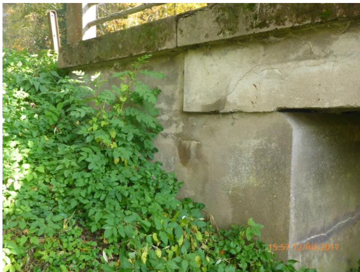
Křídlo opěry 2 vlevo Prosakování vlhkosti a výluhy.
