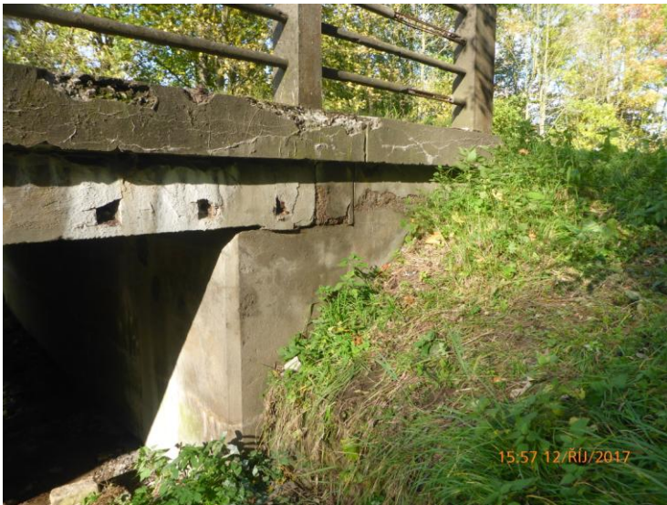
Křídlo opěry 2 vpravo. Opadává povrchová vrstva na křídle, projevy protékání křídla
